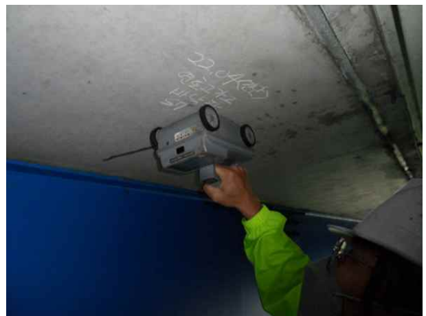
철근탐사 시험 - 피복깊이 측정
